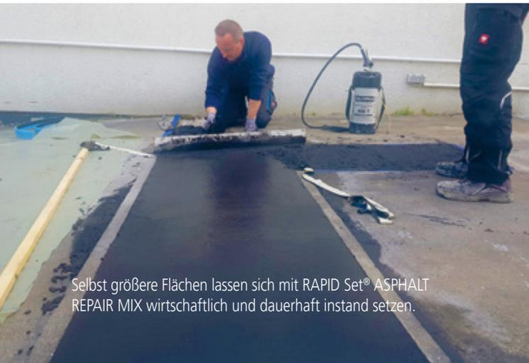
Selbst größere Flächen lassen sich mit RAPID Set® ASPHALT REPAIR MIX wirtschaftlich und dauerhaft instand setzen.
