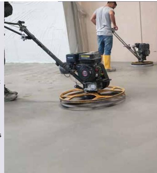
**NEODUR HE 60 rapid** matériau sec, prêt à l'emploi, à base hydraulique, à faible retrait, sur base des agrégats durs KORODUR selon la norme DIN 1100 (groupe A, M et KS). Mise en œuvre en une couche comme chape adhérente sur sol support durci pour des contraintes les plus sévères.
