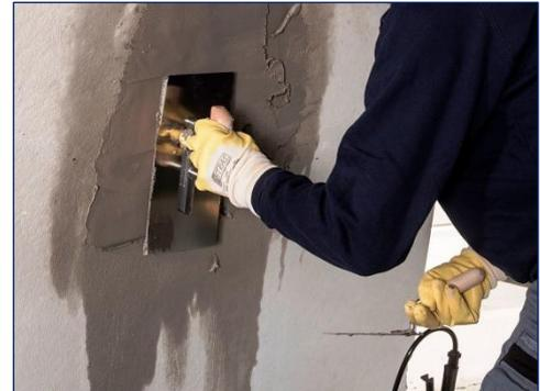
Rapid Set Reparaturmörtel können geglättet, gerieben oder mit Struktur versehen werden. Der Einbau sollte in einer kompletten Lage, d. h. nicht schichtweise und möglichst gleichmäßig erfolgen.
