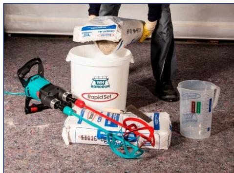
Abb. 6: Reparaturmörtel mindestens 3 Minuten mischen
