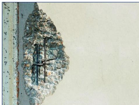
Abb. 12: Beispiel Reprofilierung der beschädigten Betonkante
