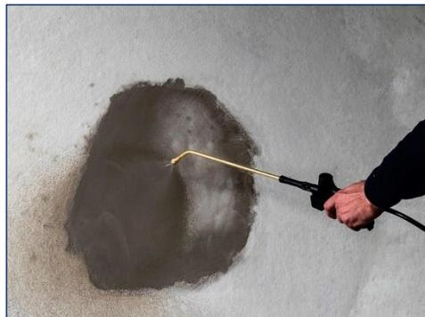
Abb. 14: Nach 1-2 Stunden ist die fertige Fläche belastbar
