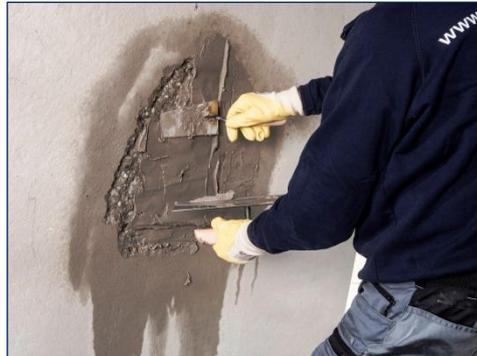
Abb. 8: Reprofilierung der beschädigten Fläche in einer Lage
