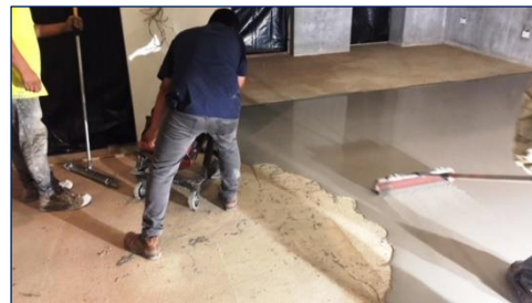
Abb. 11: Verlegung von TRU mit Hippo-Mixer
