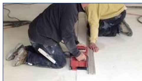
Abb. 16: Auftragen der Einpflege
