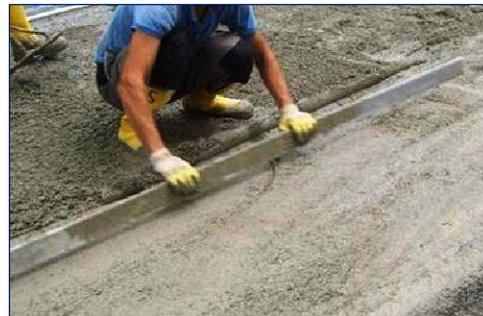
Den Hartstoffestrich über Lehren mind. 10 mm (nur bei Verwendung von handgeführten Glättern) bzw. 15 mm mittels Richtscheit oder Rüttelbohle auf die frische KORODUR Haftbrücke aufziehen.
