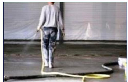
Die Oberfläche muss rissfrei, rau und offenporig sein. Geforderte Ebenheit gem. DIN 18202, Tab. 3, Zeile 3. Anschließend die Fläche gründlich von Staub und losen Bestandteilen reinigen. Sauberen Untergrund am Tag vor der Verlegung nässen.
