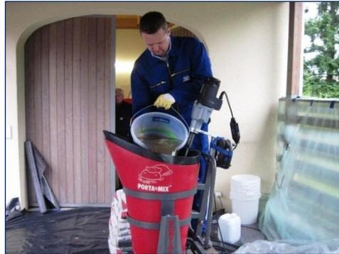
Abb. 8: Verlegung mit handgemischtem NEODUR Level
