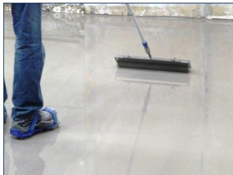
Abb. 12: Frisch verlegte Fläche NEODUR Level
