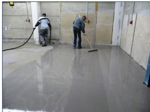
Abb. 10: Höhenverstellbarer Rakel
