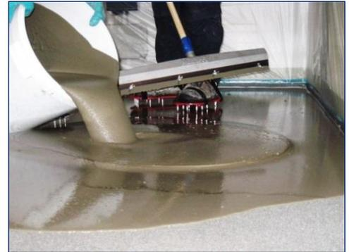
Abb. 9: Maschinelle Verlegung mit Förderschlauch NW 30
