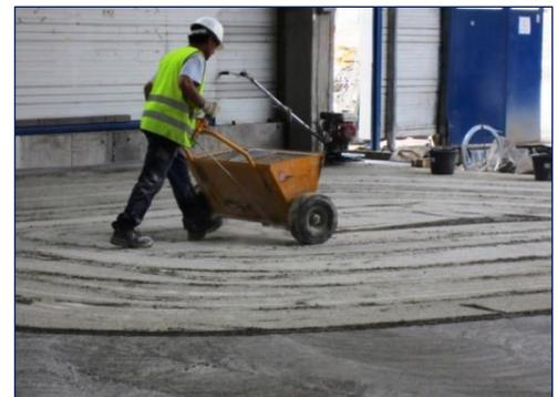
Hierdurch wird ein gleichmäßiger Auftrag des Einstreumaterials von 3-5 kg/m<sup>2</sup> erreicht. Bei Stahlfaserbeton kann auch ein Spreader eingesetzt werden.
