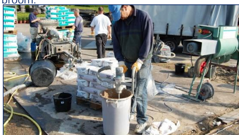
Abb. 5: Haftbrücke anmischen
