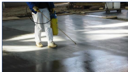
Abb. 17: Nachbehandlung mit KOROTEX
