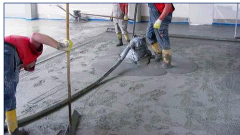
Abb. 11: Applikation mittels Druckluftförderer
