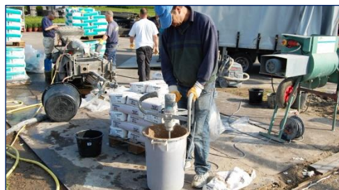
Abb. 5: Haftbrücke anmischen
