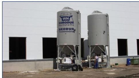
Abb. 10: Materialauftrag mittels Förderschlauch
