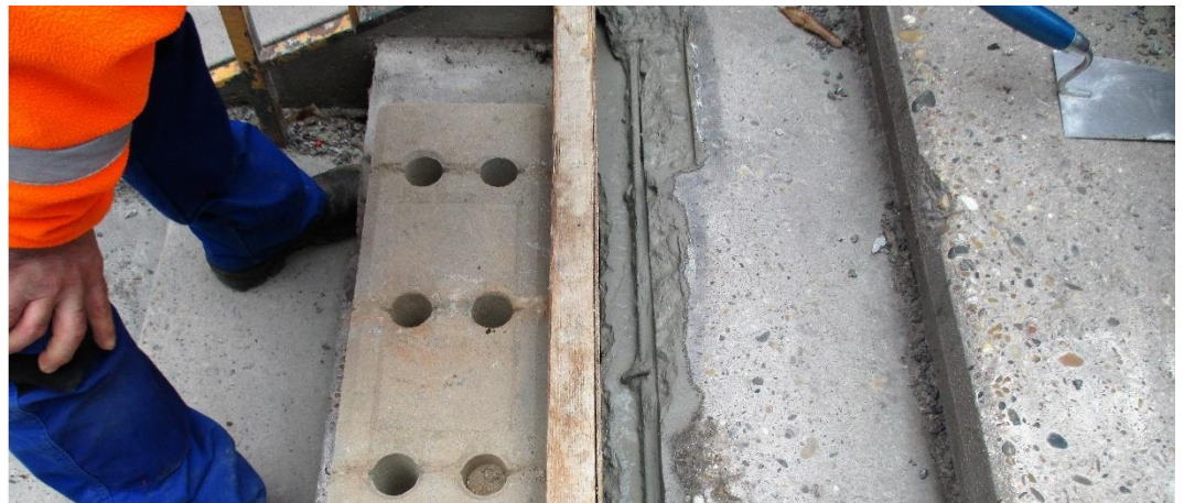
Abb. 3: Bewehrung mit streichfähigem Rapid Set Reparaturmörtel vorstreichen
