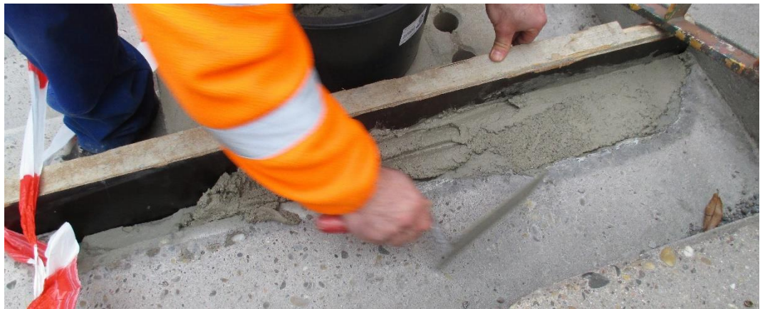
Abb. 4: Das Material auf die Schadstellen möglichst „Frisch auf Frisch“ auf den Voranstrich (s. Schritt 2) aufbringen. Je nach Lage der beschädigten Stellen z. B. an Wänden und Decken, könnte die Verwendung einer Schalung sinnvoll sein.
