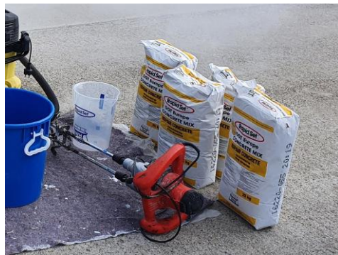
Abb. 4: Anmachwasser mit 5 Liter Messbecher abmessen und in den Mischeimer vorgeben
