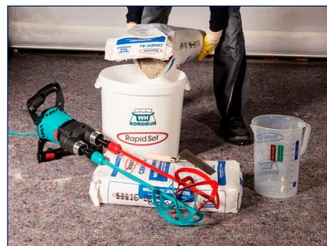
Abb. 6: Reparaturmörtel mindestens 3 Minuten mischen
