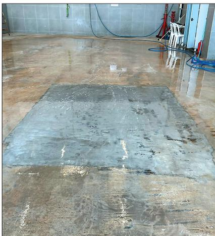
Um dem Auftraggeber die Wirksamkeit aufzuzeigen, wurde zunächst probeweise ein Teilstück saniert und auf die Widerstandsfähigkeit gegen Verschleiß und Abrieb hin getestet.
