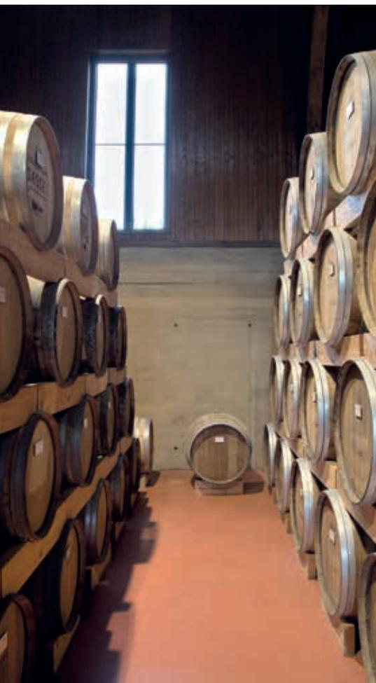
Der Hallenboden im Reifugium ist verschleiß-, rutsch- und wasserfest. Seine rote Einfärbung entspricht dem ästhetischen Konzept des Architekturbüros. Foto: concrete content/C. Jahn
