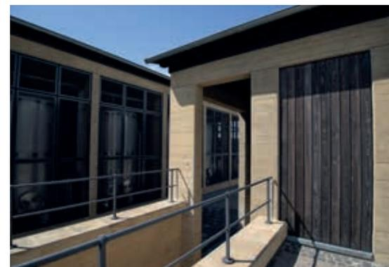
Das Brunnenhaus, in dem sich die eigene Quelle befindet ist ebenfalls mit dem sandsteinfarbenen Beton erbaut. Das Lager ist nach drei Seiten offen, die vierte Seite durch die Brandmauer abgeschlossen.
