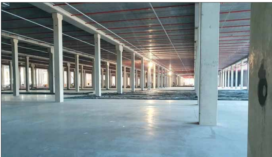
Für Industrieböden, die besonders abriebfest und verschleißfrei sein müssen, ist Neodur HE 3 von Korodur konzipiert. Neben der Logistik inklusive Hochregallagern sind Parkhäuser, Industrie-, Montage- und Flugzeughallen sowie Werkstätten typische Einsatzorte.
