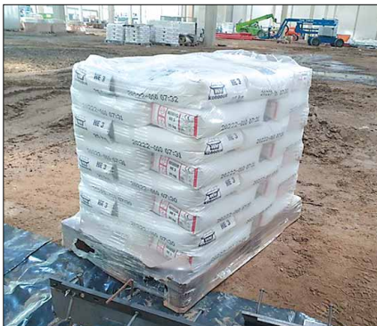
Rund 500 t Neodur HE 3 wurden im Zalando-Logistikzentrum in Bydgoszcz verlegt.
