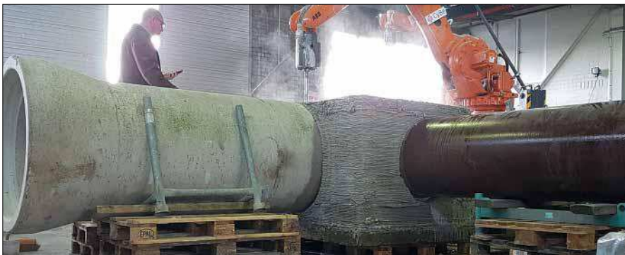
Vielfältige Anwendungsmöglichkeiten haben sich bereits ergeben – darunter der passgenaue Bau von Schächten für unterirdische Versorgungsungen und vieles mehr.
