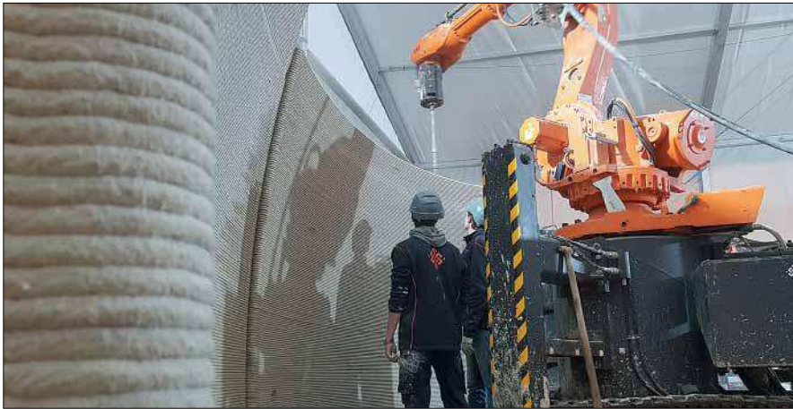
Schicht für Schicht entstehen die Wände und Säulen. Bei dieser Bauweise werden keine Schalungen benötigt.
