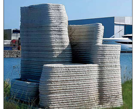
Dank des von Korodur entwickelten Baustoffs CyBe Mortar können Elemente in einem kompletten Stück gefertigt werden.
