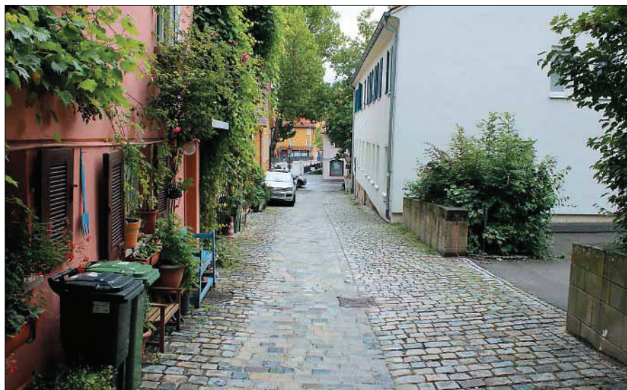
Die Sanierungen wurden teilweise durch Gefälle und Granitsteine im bestehenden Pflaster erschwert.
