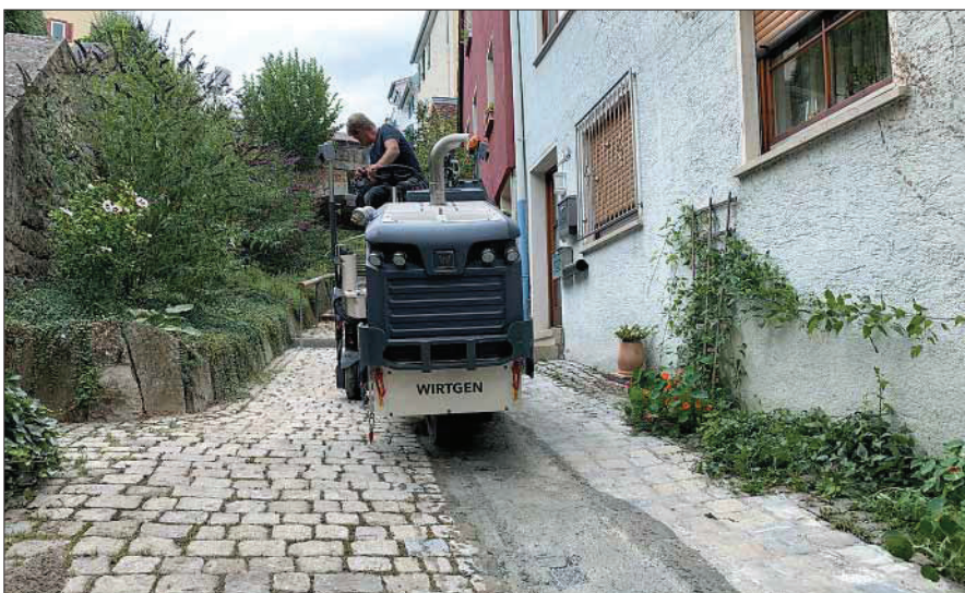
Der beauftragte Betonsanier- und Verlegebetrieb Blessing hat das System gemeinsam mit dem Hersteller Korodur entwickelt.
