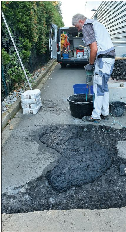
*Mit dem Rapid Set®-Reparaturmörtel lassen sich Böden – ebenso wie Decken und Wände – innerhalb kürzester Zeit herstellen bzw. sanieren. Die Lebensdauer ist bei normaler Beanspruchung dreimal so hoch wie bei herkömmlichem Portlandzement – ein klares Plus auf lange Sicht.*
