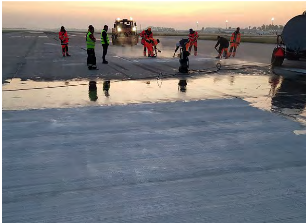
réparation à l'aéroport (enlèvement et installation pendant la nuit)
