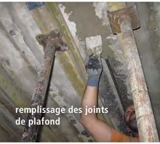
réparation étanche aux liquides dans les stations-service
