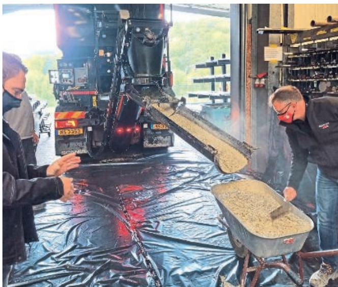
Schubkarrenweise wurde der Korocrete-Beton vor Ort angemischt und zu der zu sanierenden Fläche transportiert.
