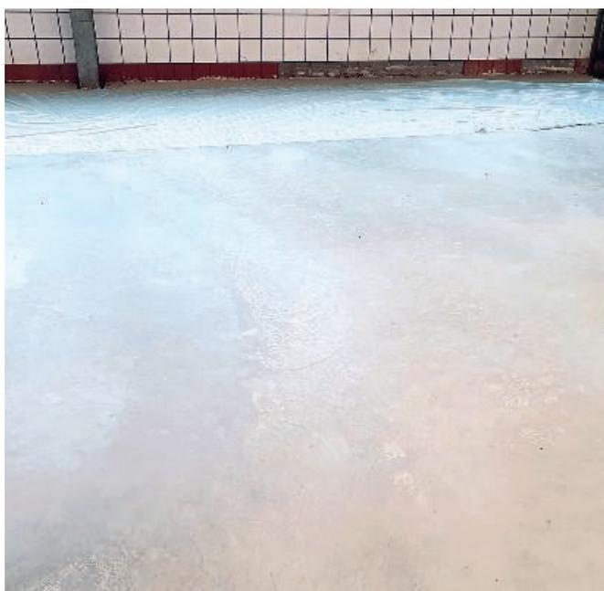
Um den jungen Beton vor äußeren Einflüssen zu schützen, wurde die Fläche abschließend mit einer Folie abgedeckt.
