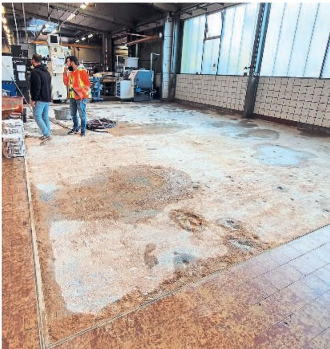
Zur Vorbereitung wurde die Fläche am Vortag per Kugelstrahlverfahren von Fliesen und Estrichresten befreit und wassergesättigt.
