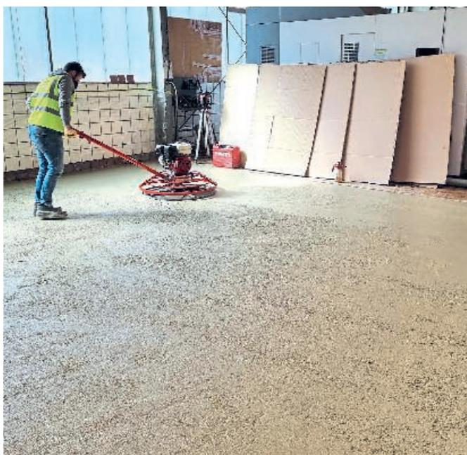
Im Anschluss an das Verteilen des Betons konnten die Estrich-Experten direkt damit beginnen, die Fläche zu glätten.
