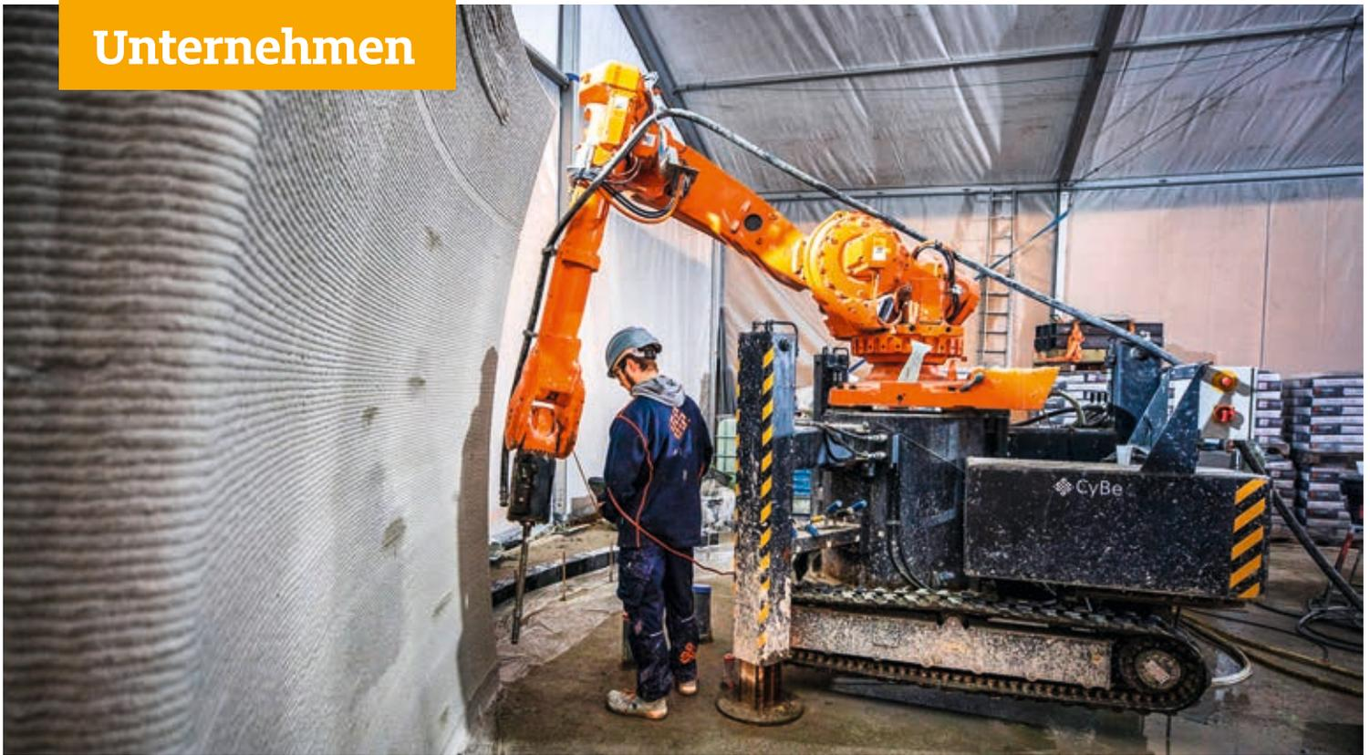
Mitten in der Wüste Dubais wurde per 3D-Betondruck innerhalb von drei Wochen ein Gebäude fertig gestellt. Den innovativen Zement dafür entwickelte Korodur.
