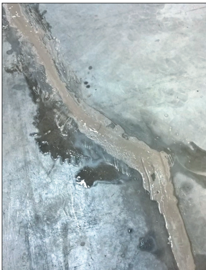
Ein typischer Anwendungsfall sowohl für Epoxidharze als auch für mineralische Mörtel sind Reparaturen wie solche Fugensanierungen.
