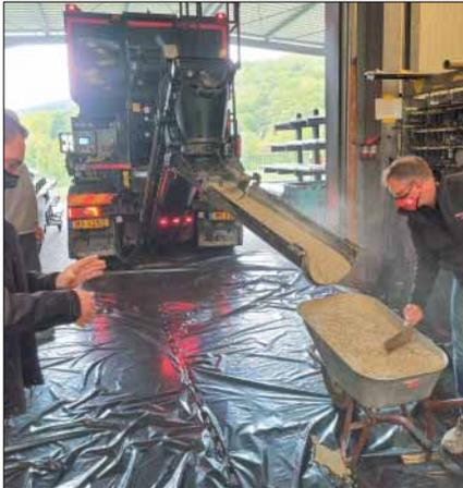
*Schubkarrenweise wurde der Korocrete Beton vor Ort angemischt und zu der zu sanierenden Fläche transportiert.*
