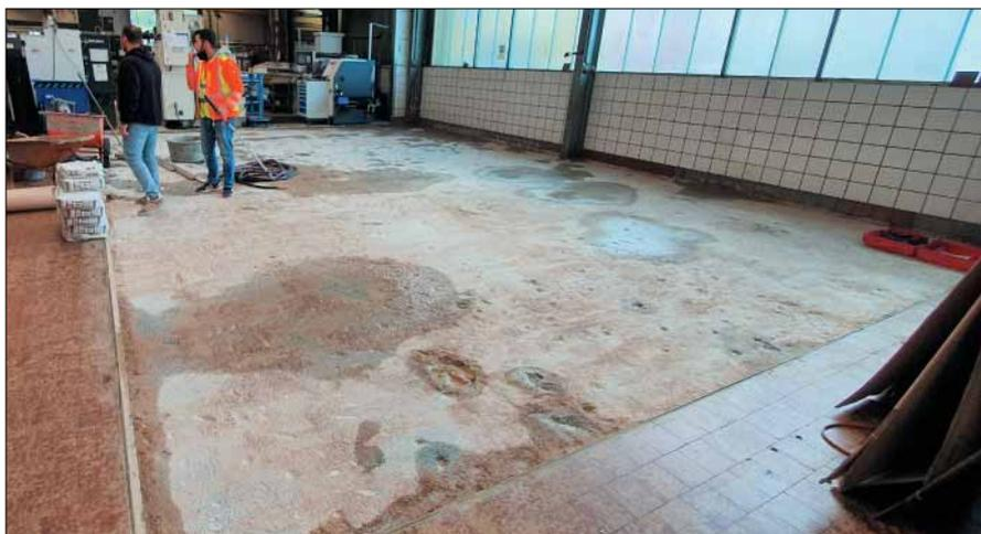
*Zur Vorbereitung wurde die Fläche am Vortag per Kugelstrahlverfahren von Fliesen und Estrichresten befreit und wassergesättigt.*
