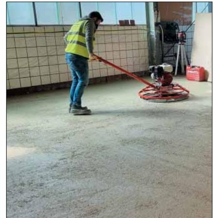
*Im Anschluss an das Verteilen des Betons konnten die Estrich-Experten direkt damit beginnen, die Fläche zu glätten.*
