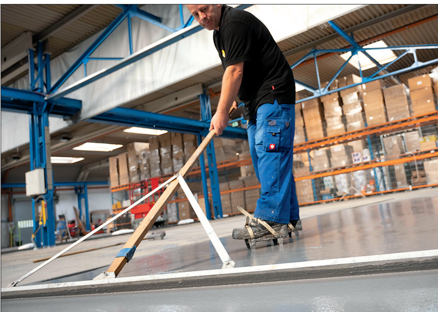
Mit handwerklichem Geschick wird das Material für den Magnesitestrich mit einer Stärke von im Mittel 17,5 mm verteilt.
