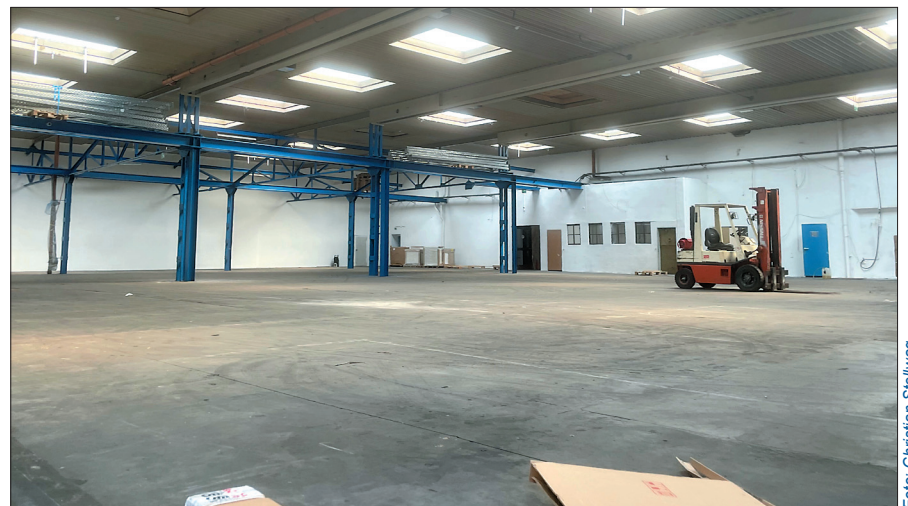
Die Erneuerung des Industriebodens ist nur ein Teil der Sanierungsmaßnahmen.
