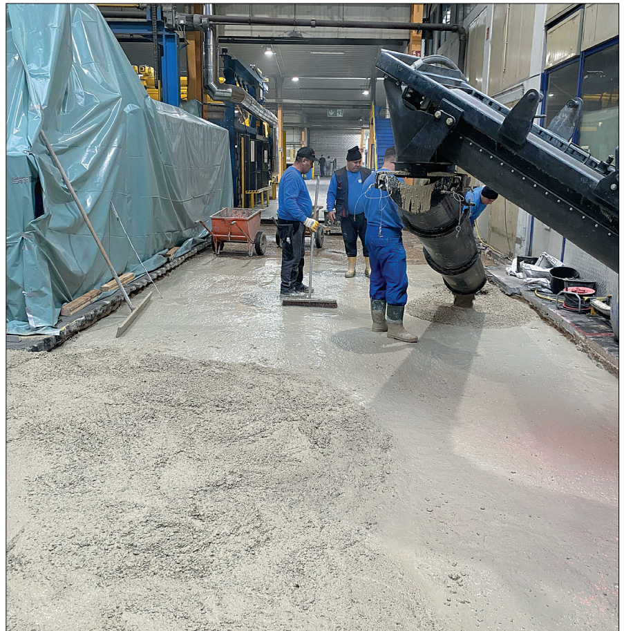
Nachdem das im Mörtel-Mich-Lkw angemischte Material Korocrete über Mischschnecke und Rutsche zur Einbaustelle gelangt war, musste es von den Experten der IB West zügig, aber sorgfältig verteilt werden, um eine homogene Fläche ohne sichtbare Anschlüsse herzustellen.
