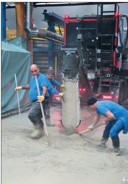
Durch den Einsatz des Sattelauflegers mit Kran von Mörtel Mich konnte das Sand-Kies-Gemisch während des Einblasens von FSCem autark nachgeladen werden.
