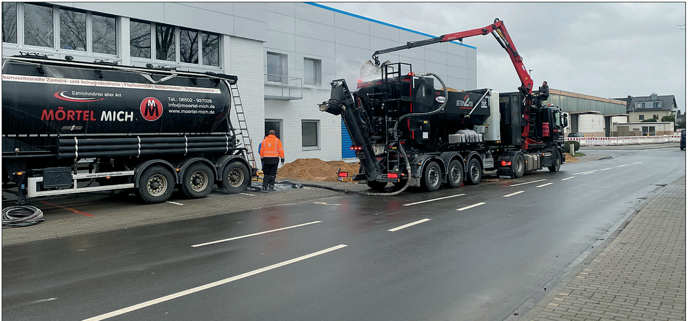
Durch den Einsatz des Sattelauflegers mit Kran von Mörtel Mich konnte das Sand-Kies-Gemisch während des Einblasens von FSCem autark nachgeladen werden.
