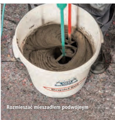
Aplikowanie zaprawy naprawczej Rapid Set®
