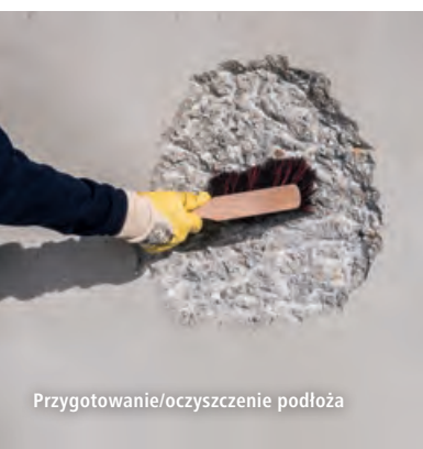
Oczyszczone powierzchnie zmożyć wodą
