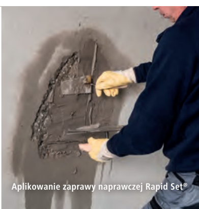
Wyrównywanie powierzchni
