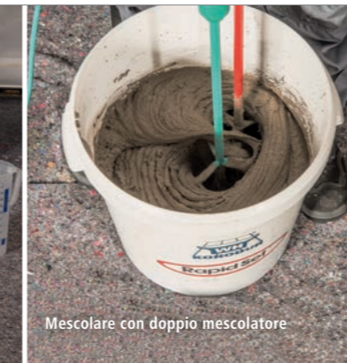
Riprofilatura con malta da ripristino Rapid Set®
