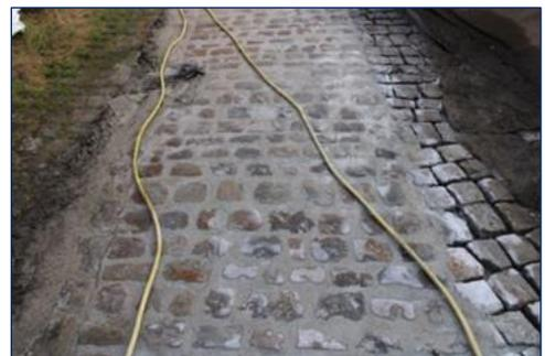
Abb. 2: Mit MORTAR MIX ausgefugte Fläche
