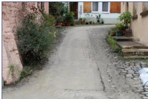
Abb. 4: Ausgefugte Fläche, welche anschließend mit Wasserhochdruck gereinigt wurde
