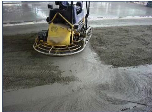
Abb. 8: Glätten der Fläche mit Doppelglätter
