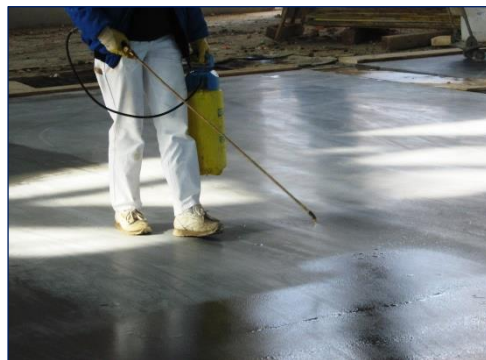
Abb. 10: Nachbehandlung mit KOROMINERAL CURE
