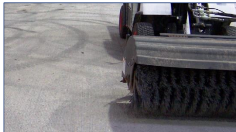
Abb. 4: Untergrund mattfeucht vornässen
