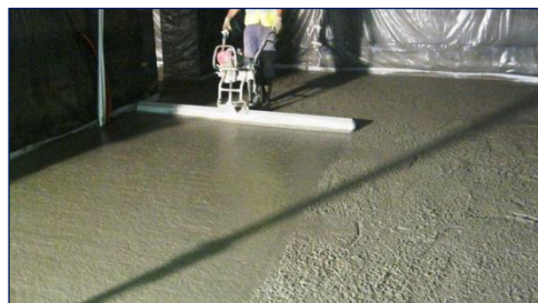
Abb. 14: Reiben mit Tellerglättmaschine (abtellern)
