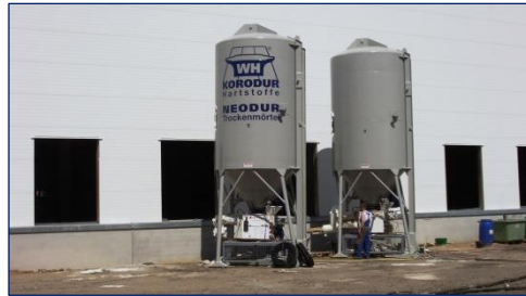
Abb. 10: Materialauftrag mittels Förderschlauch
