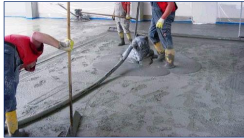
Abb. 11: Applikation mittels Druckluftförderer
