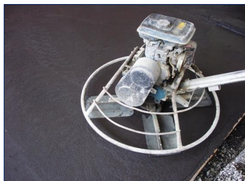
Abb. 10: Nachbehandlung mit KOROMINERAL CURE oder KOROTEX
