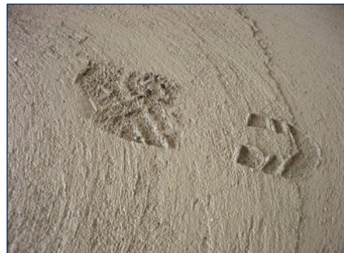
Abb. 2: Auftellern (Durchreiben) des Tragbetons
