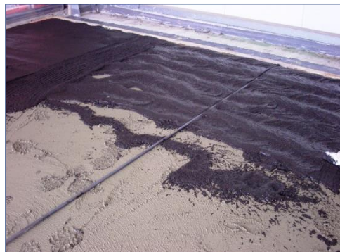
Abb. 8: Verlegung Hartstoff-Industrieboden „Frisch auf Frisch“ über Rundeleisen (Abziehlehren)
