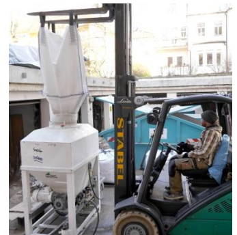
Befüllung mit Big-Bags auf der Baustelle
