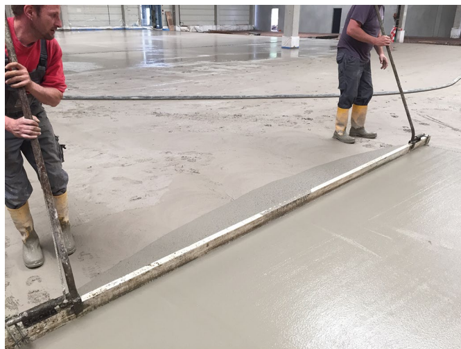
Bild 2 Präzise Einbauleistung durch den Industriebodenspezialisten CONDULITH® Deutsche Industrieböden GmbH
